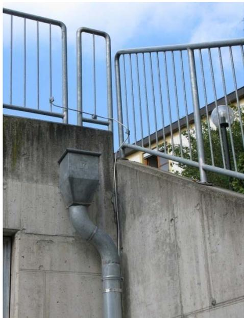
Bild 78 ordnungsgemäße Einbindung Regenabfallrohr
