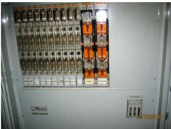
Bild 14 Hauptverteiler NH Abgänge
