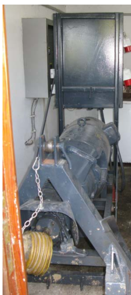
Bild 32 Netzersetzaggregat
