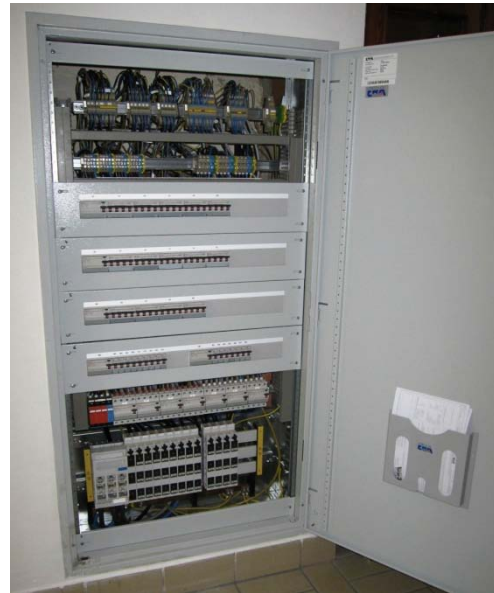
Bild 13 a Überprüfung der Nullungsverbindung
