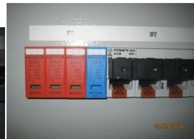
Bild 15 Überspannungsschutz
