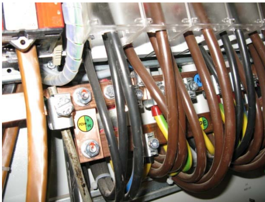
Bild 12 PEN Auftrennung in PE und N
