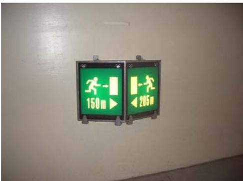
Positiv aufgefallen ist, dass eine Eigenentwicklung der LBD zur Montage von Fluchtwegorientierungsleuchten führte, die aus einem vorbeifahrenden Auto gut ablesbar sind.
