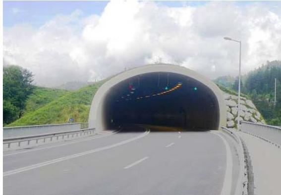
Der 115,5 m lange Tunnelneubau stellte die eigentliche Verlängerung des Lawinenschutzes dar, der bereits in Form einer Lawinengalerie in einem Teilstück des Bauloses gegeben war. Der gesamte Tunnel wurde nach Angaben, die aus dem naturschutzrechtlichen Verfahren vorgegeben waren, eingeschüttet und begrünt. Die notwendigen betriebs- und sicherheitstechnischen Einrichtungen sind vorhanden.
