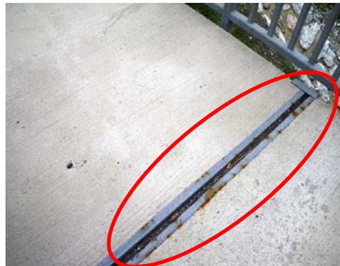
**Im Bereich der Brücke wurden an den Dilatationen einige Korrosionsschäden festgestellt. Es ist nicht ausgeschlossen, dass dies auch bei den nicht zugänglichen Teilen der Fall ist. Diese Mängel fallen unter die noch laufende Gewährleistung und sollten rasch behoben werden, um größeren Schaden zu vermeiden.**
