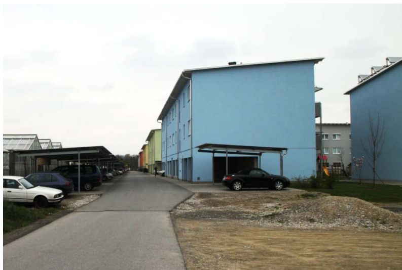
Gesamtanlage, Blickrichtung Osten
