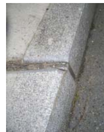
Randleistenkante gebrochen
