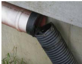
Aufgegangene Rohrverbindung
