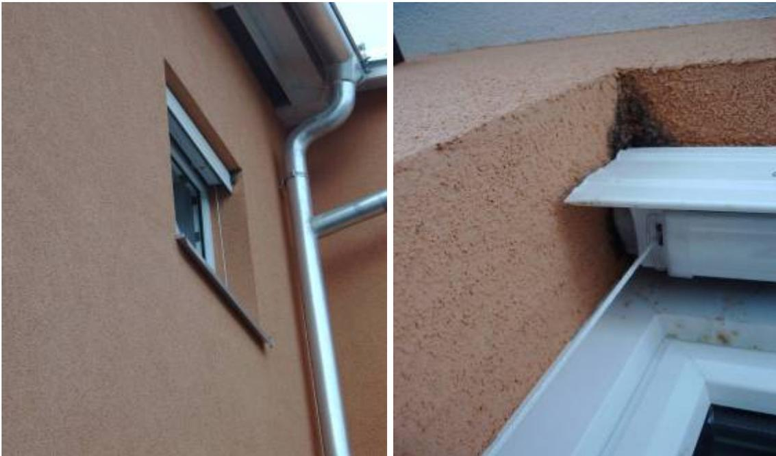
Bei etlichen Fensterecken sind schwarze, schimmelige Stellen zu bemerken. Der Grund dafür ist nach Aussage der WBVE, dass sich dort, wo die Führungsschnur der Jalousie durch den Fensterstock geht, eine kleine Öffnung befindet. An diesen Stellen kommt es zu Kondensationen mit den vorhin beschriebenen Folgen. Durch ein entsprechendes Lüften der betroffenen Räume kann eine Verbesserung der derzeitigen Situation herbeigeführt werden.
