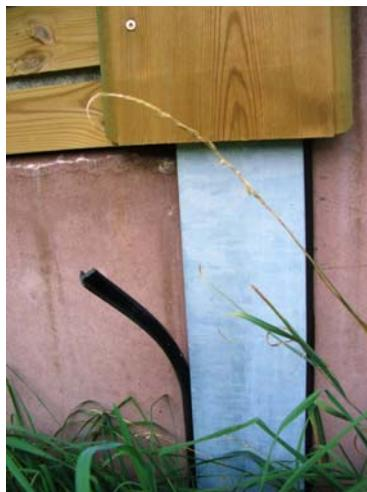
Die Ausleitung des Drainagerohres wurde nicht entsprechend ausgeführt. Im Zuge von Mäharbeiten wurde das Rohr bei der Ausleitung beschädigt. Kleine Kunststoffteile liegen auf der Böschung verstreut.
