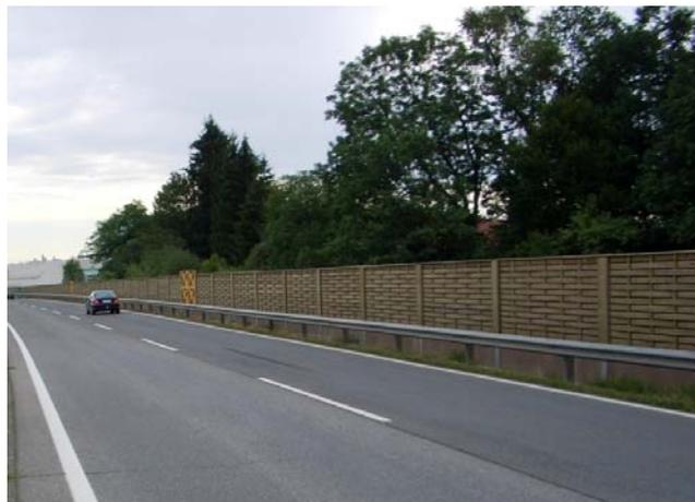
Im zweiten Bauabschnitt, im Bereich Eibiswald (km 43,1 bis km 43,2) wurde eine 73 m lange Lärmschutzwand in Flechtholzelementen errichtet.
