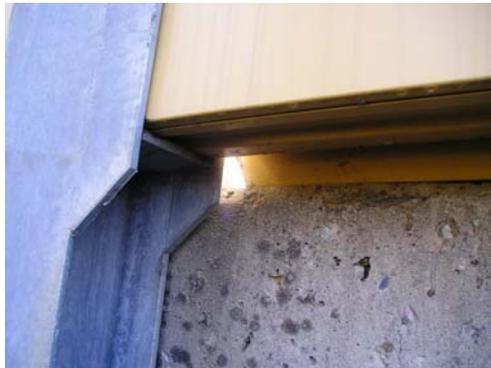
Die Dichtung zwischen Betonsockel und Steher wurde nicht entsprechend fixiert und steht heraus.
