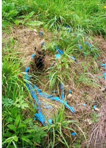
Der LRH ist der Meinung, dass die Beschädigung des Drainagerohres beim Mähen hätte auffallen müssen und zumindest die Kunststoffsplitter umgehend entfernt hätten werden müssen.
