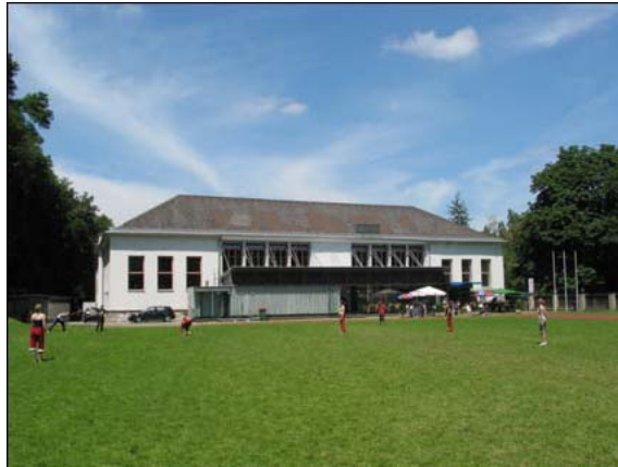
Landessportzentrum (ehem. Landesturnhalle)
