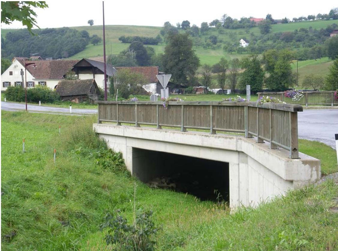
Der Lammbach wurde im unmittelbaren Nahebereich der Brücke geringfügig adaptiert und im Tragwerksbereich eine Tiefenrinne mit einer Breite von 1,5 m und einer Tiefe von 0,30 m eingebaut. Aufgrund der Neutrassierung des Straßenkreuzungsbereiches wurde die Lage der neuen Brücke gegenüber der ursprünglichen Brücke etwas verändert. Für die Verkehrsaufrechterhaltung während der Bauzeit konnte daher die alte Brücke verwendet werden.
