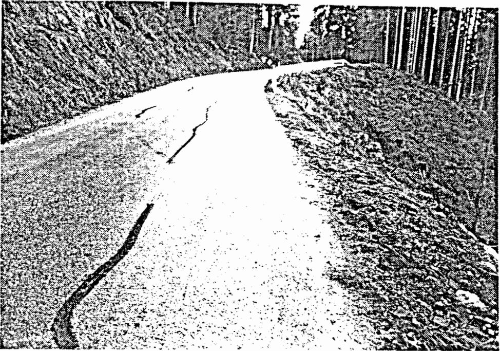
Wegprojekt Gumpenberg - Walddurchfahrt im unteren Teil. Durch Erosionsschäden beginnende Rutschung mit verklebten Asphalttrissen.
