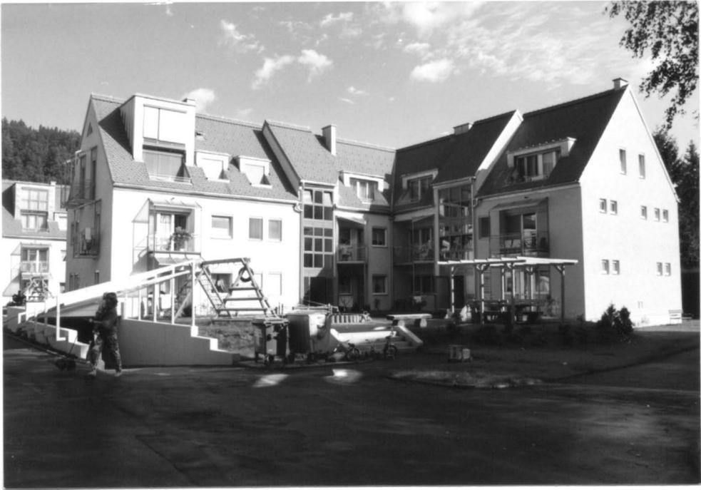
Die Wohntrakte bestehen aus 2 Vollgeschoßen und einem ausgebauten Dachgeschoß mit teilweise eingeschnittenen Dachterrassen.
