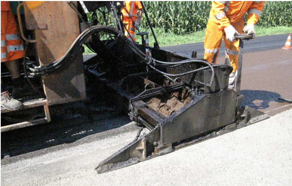
Abb.: Aufbringung einer Dünnschichtdecke im Kaltverfahren (DDK) im Bereich Frauental
