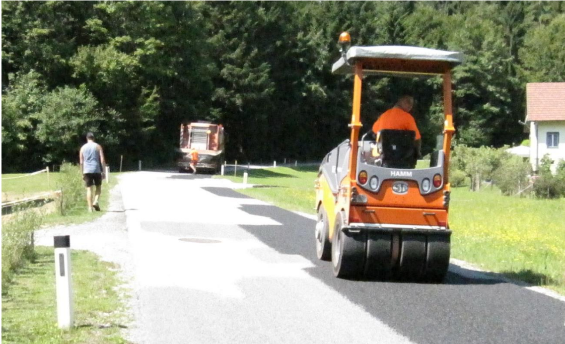
Abb.: Straßensanierung mittels „Einfacher Oberfläche“ im Bereich Stiwoll mit landeseigenen Geräten
